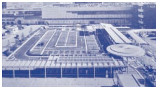
金沢駅西広場整備事業が完成。27億円が投入
